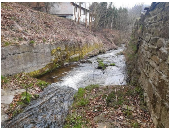
Foto 9: : Konec opevnění koryta pod silničním mostem SM2. konec navržených úprav.
